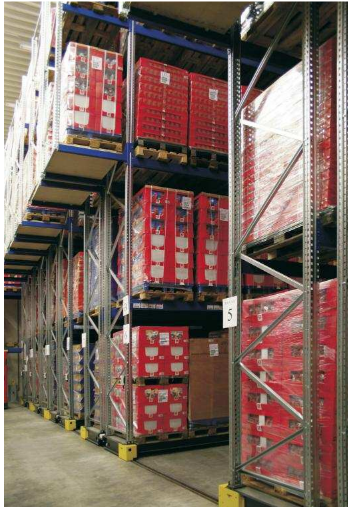
Das Nürnberger Kühllager von Lambert ist mit Verschieberegalen – gesteuert durch ein Aisys-LVS-System – ausgestattet
